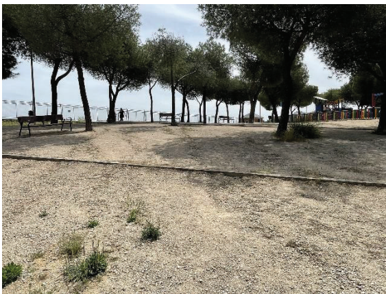
Problemas de escorrentía en terrizo de pinar norte, pese a la existencia de encintados de rigola
