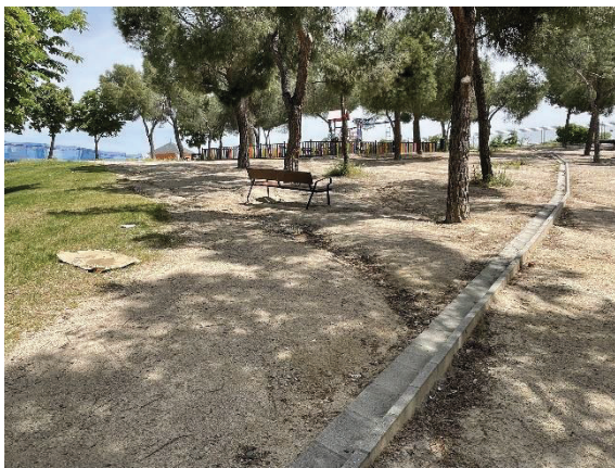
Cárcavas existentes en el pinar sur
