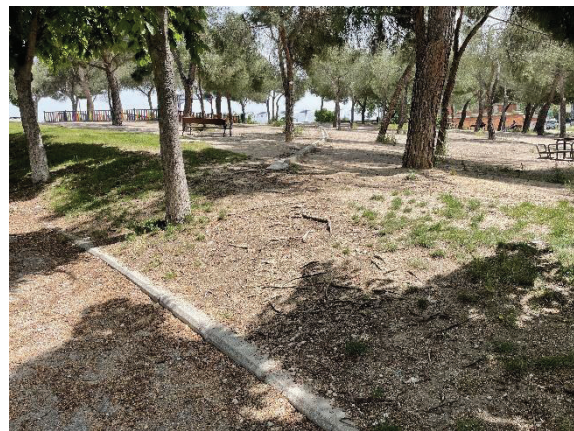
Arrastre de materiales en el punto de vertido del rigola
