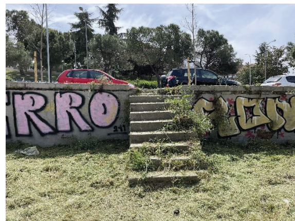
Escalera acceso en la zona sur del parque forestal
