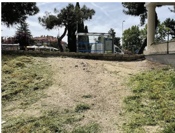
Acceso sur con graves problemas de accesibilidad
