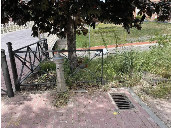
Fuente de beber existente junto a la pasarela
